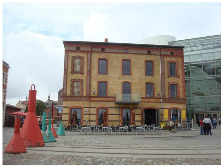
Het gebouw na de renovatie., Het Ozeaneum is in de lege ruimte er naast gekomen.
